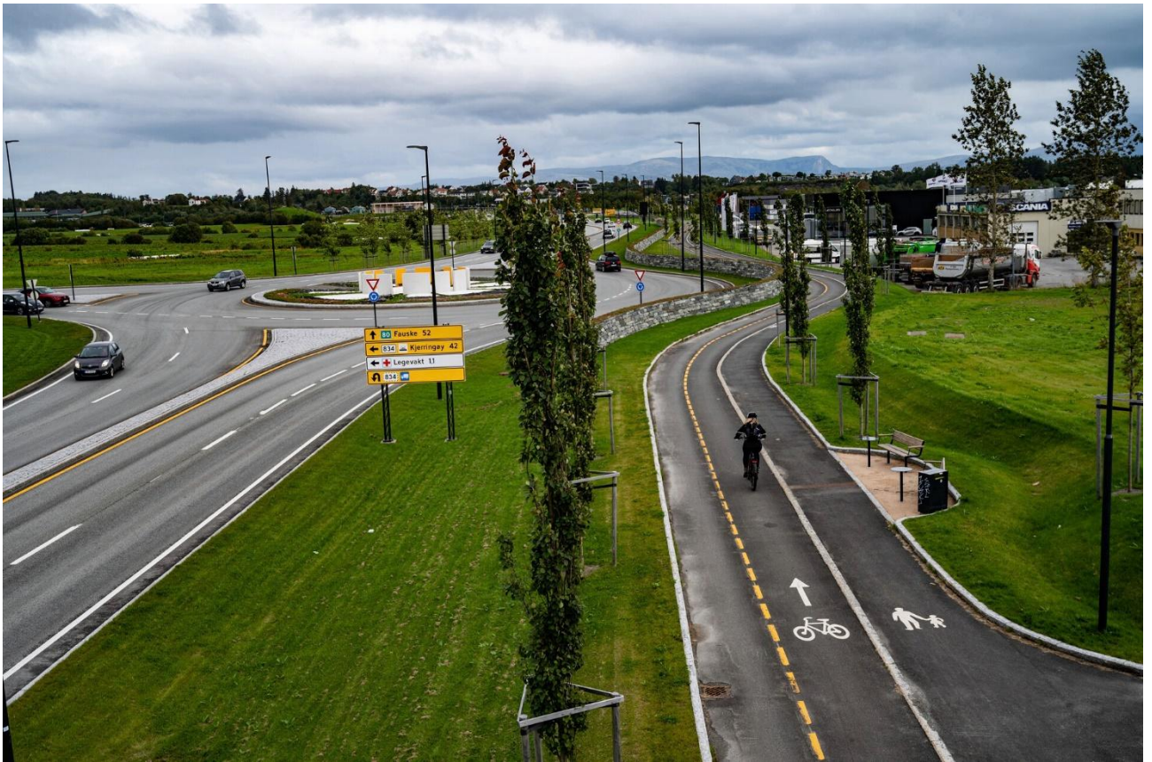
Foto. Bård Asle Nordbø – Statens vegvesen
