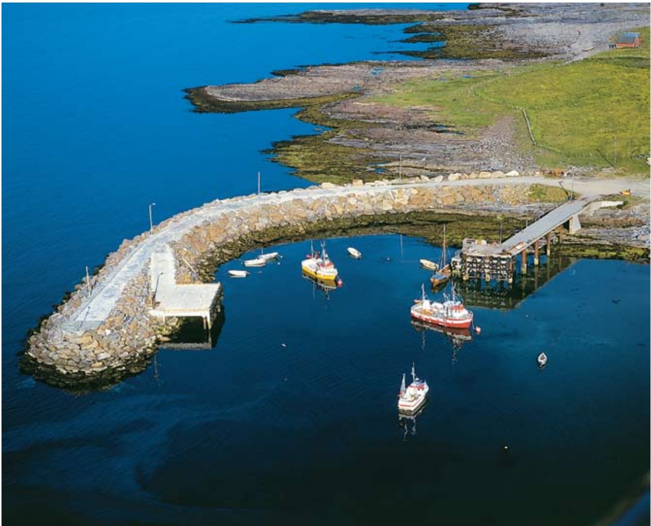
MEVÆRET, Loppa, sett fra W (1998)
