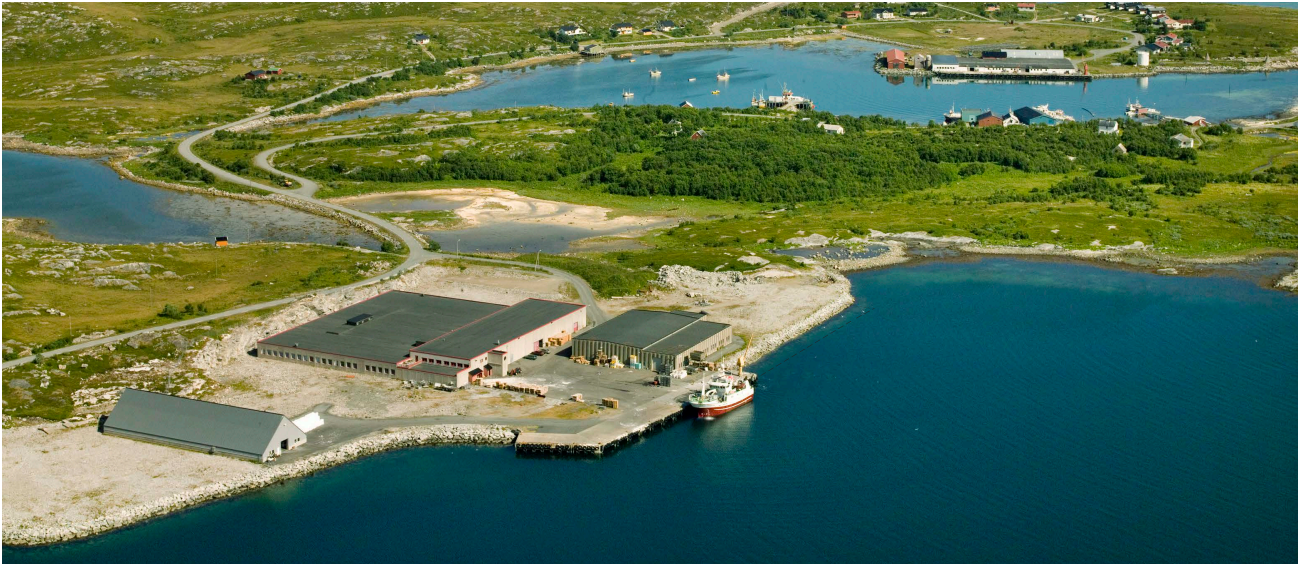
VANNAVALEN, Industrikaia, sett fra SW (2007)
