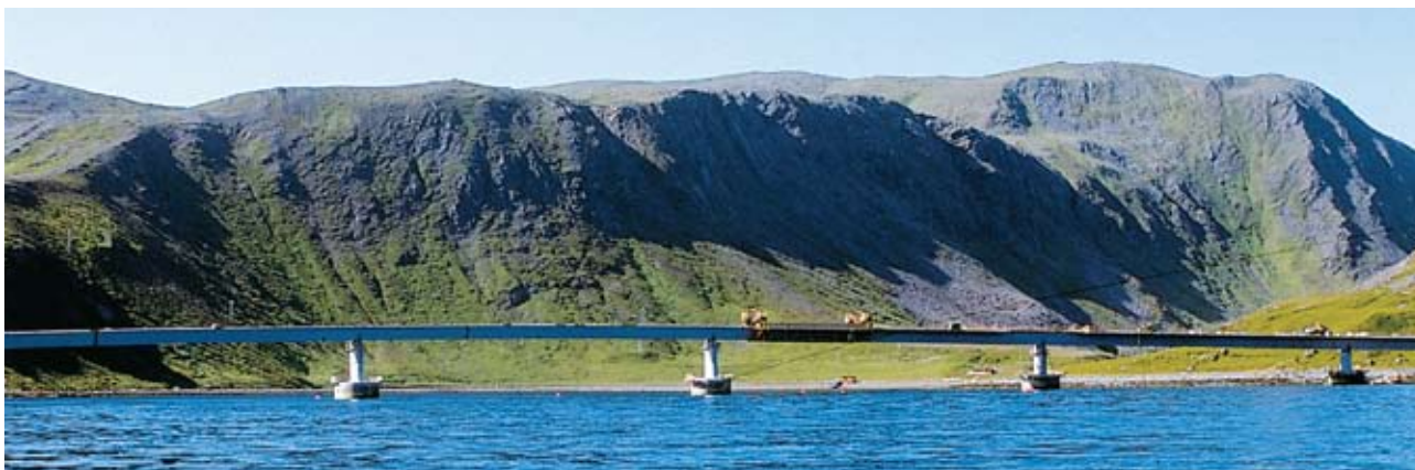
Brua ved KOBBHOLNESET (10) sett fra E (1998)
