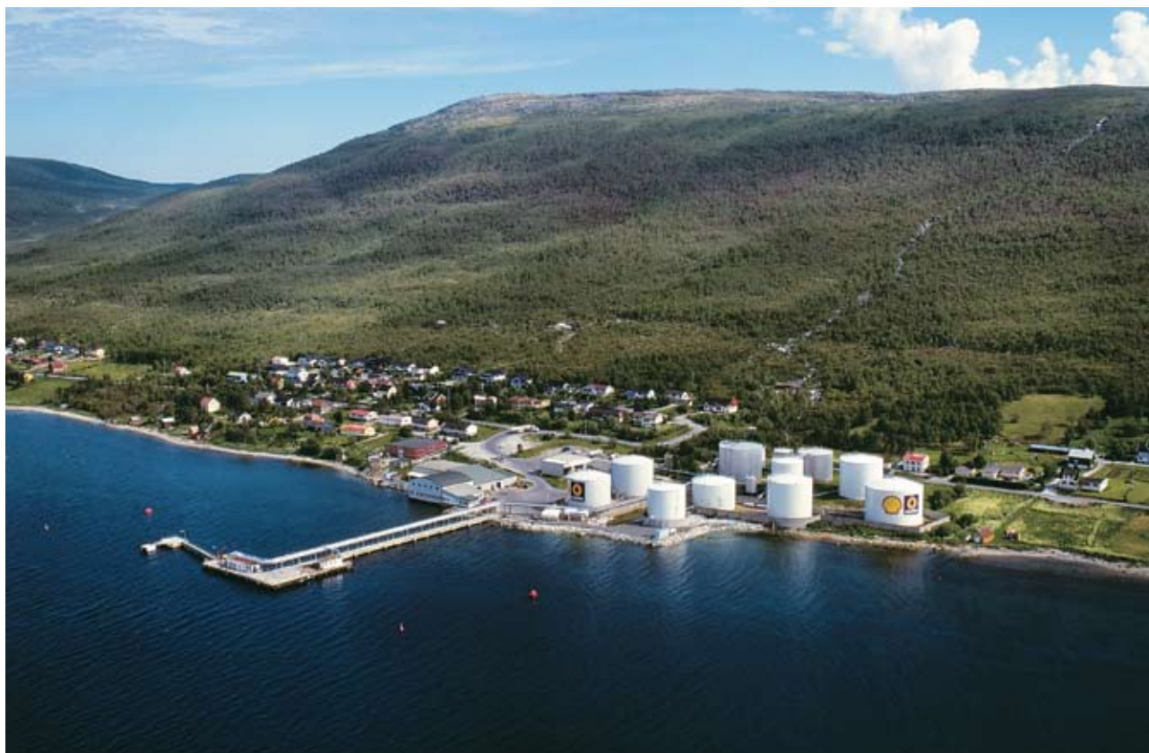
SKJELNAN, tankanlegg, sett fra SW (1998)
