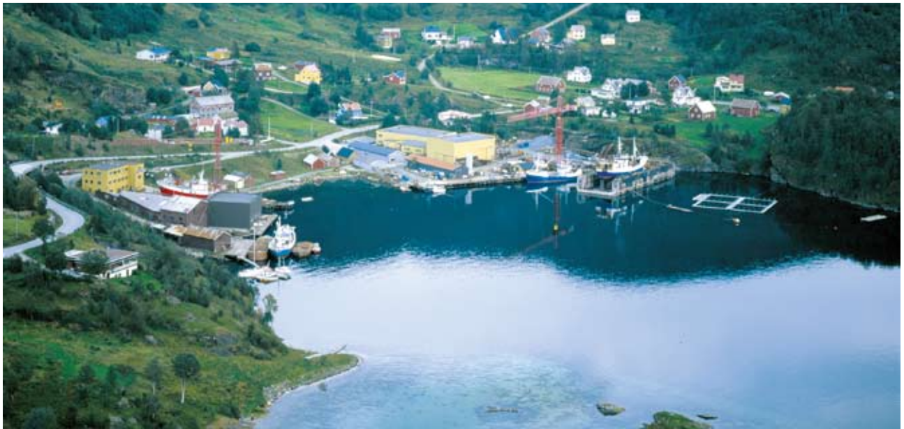
GROV sett fra SW (1998)
