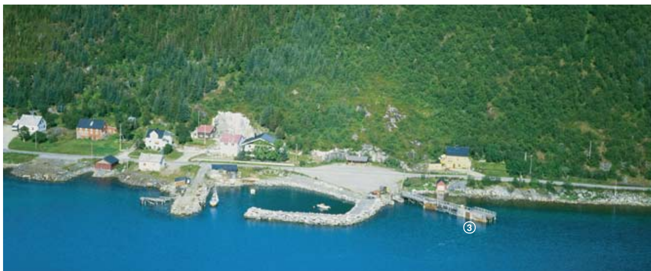
SKALAND, nedlagt ferjeleie, sett fra S (1998)
