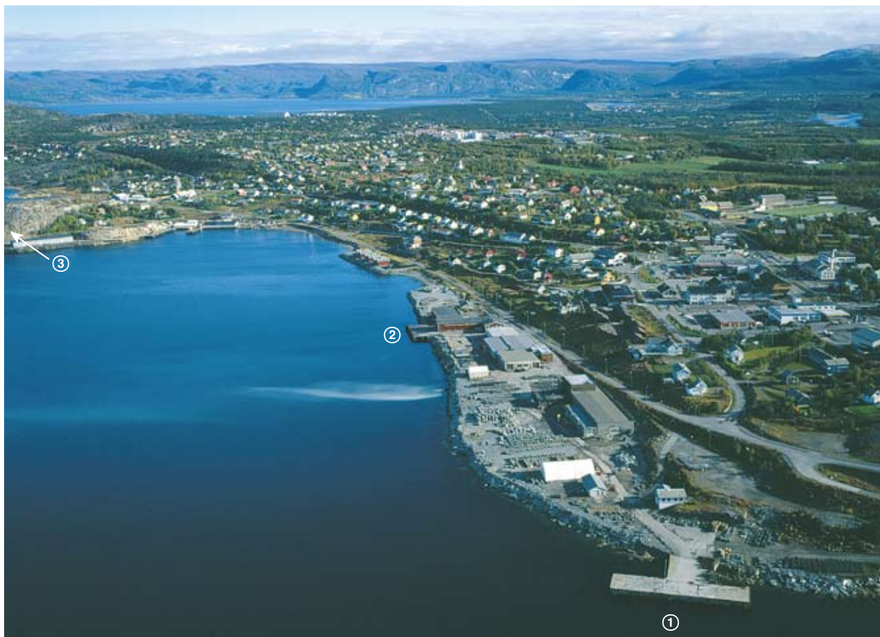
BOSSEKOP, Alta, sett fra SW (1998)
