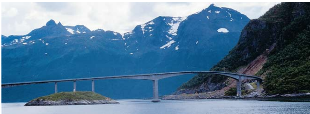
MJØSUND BRU (35) sett fra NW (1998)
