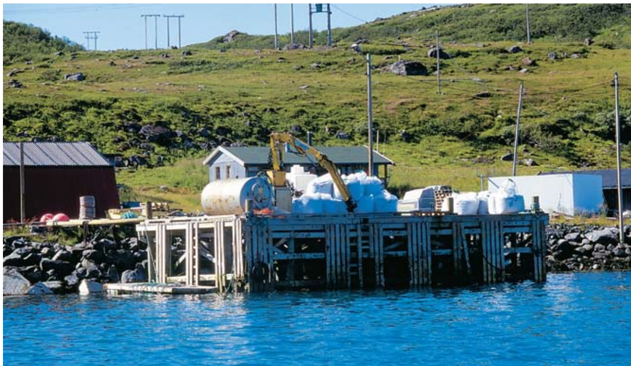
Allmenningskaia i DØNNESFJORDBOTN, sett fra NE (1998)
