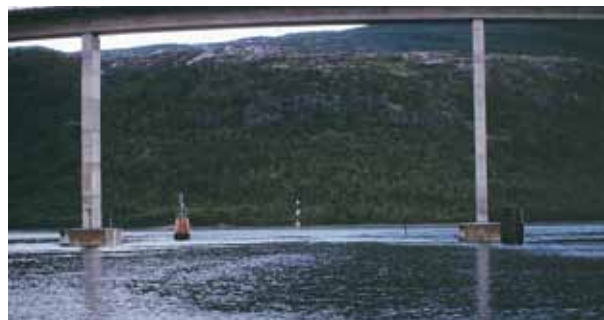
Brua over SPANNBOGSTRAUMEN med overetten sett fra SE (1998)
